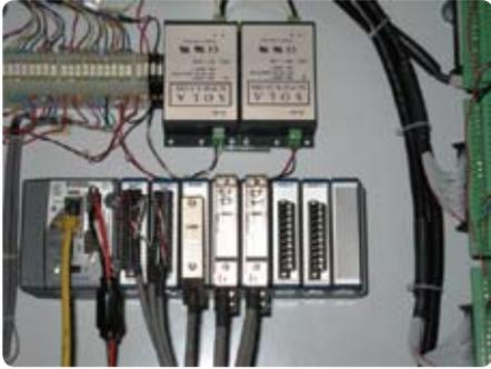
图2 基于FPGA和实时控制器的CompactRIO平台
